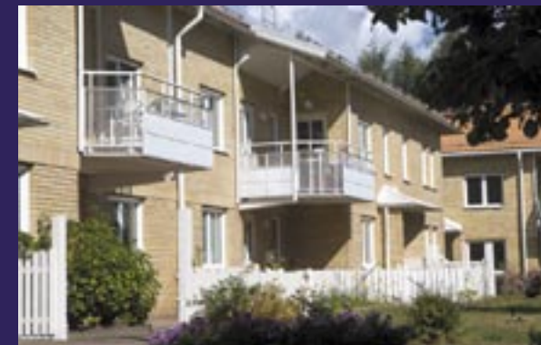
Svenska Bostäders kv. Gulddragaren Stockholm. 3 600 PVC-fönster monterade med start hösten 1987
