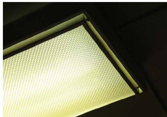
Fig 38. Raster till lysrör PMMA används mycket inom belysningsindustrin.
