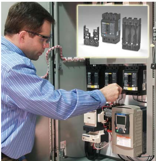
Fig 41. Polyamid har en utmärkt kombination av bra elektriska egenskaper, hög användningstemperatur och flamskyddsmöjlighet (upp till UL V-0 klassning). Materialet används därför mycket till elektriska komponenter såsom säkringar, brytare, transformator kåpor etc. Foto: DuPont
