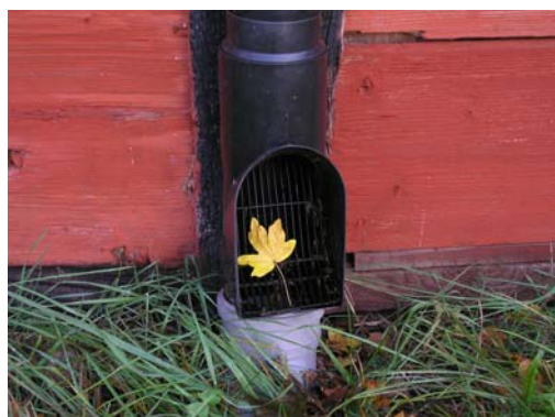
Fig 116. Många plastdetaljer såsom denna lövrensare till ett stuprör skall hålla i åtskilliga år utomhus. För att hållfastheten inte skall försämrats väljer tillverkarna speciella UV-stabiliserade kvalitéer.
